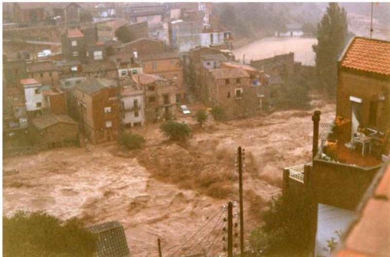
Figura 7.- Riuada de 9 i 10 d'octubre de 1994 passant per sobre del pont de Cal Cisquet on es troba situada l'EA29C
